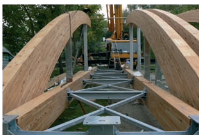
Passerelle lamellé-collé en mélèze - Arcs porteurs avec berceaux métalliques de suspension
