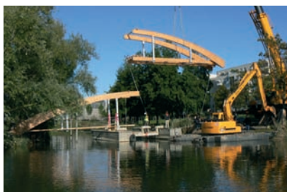
Passerelle lamellé-collé en mélèze - Arcs porteurs avec berceaux métalliques de suspension
