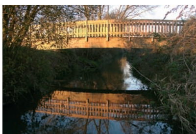
Passerelle cintrée en pin lamellé-collé - Platelage en pin rainuré traité autoclave classe IV
