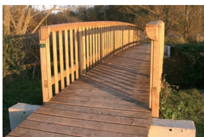
Passerelle cintrée en pin lamellé-collé - Platelage en pin rainuré traité autoclave classe IV
