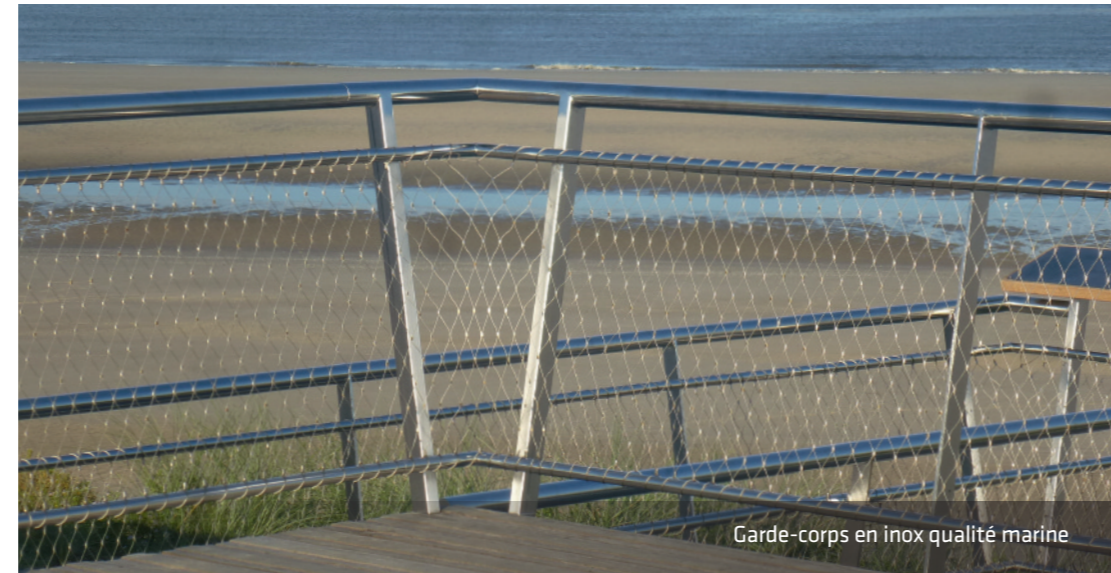
Remplissage mixte filet maille inox sur tubes/câbles inox Poteaux thermolaqués - Main courante en bois
