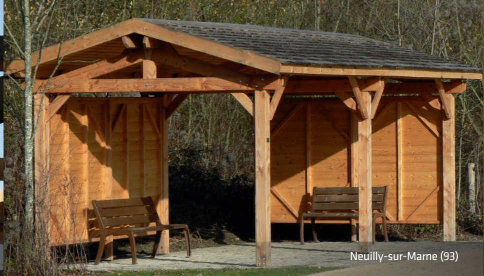
Charpente en chêne
