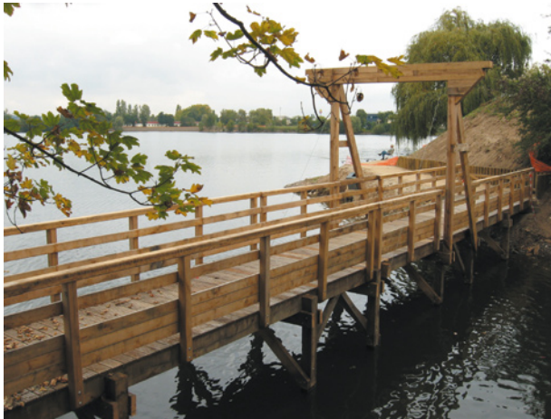
Pont-levis sur portiques - structure, platelage, garde-corps en chêne
