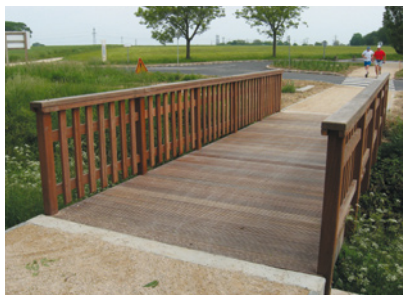
Pont-levis sur portiques - structure, platelage, garde-corps en chêne
